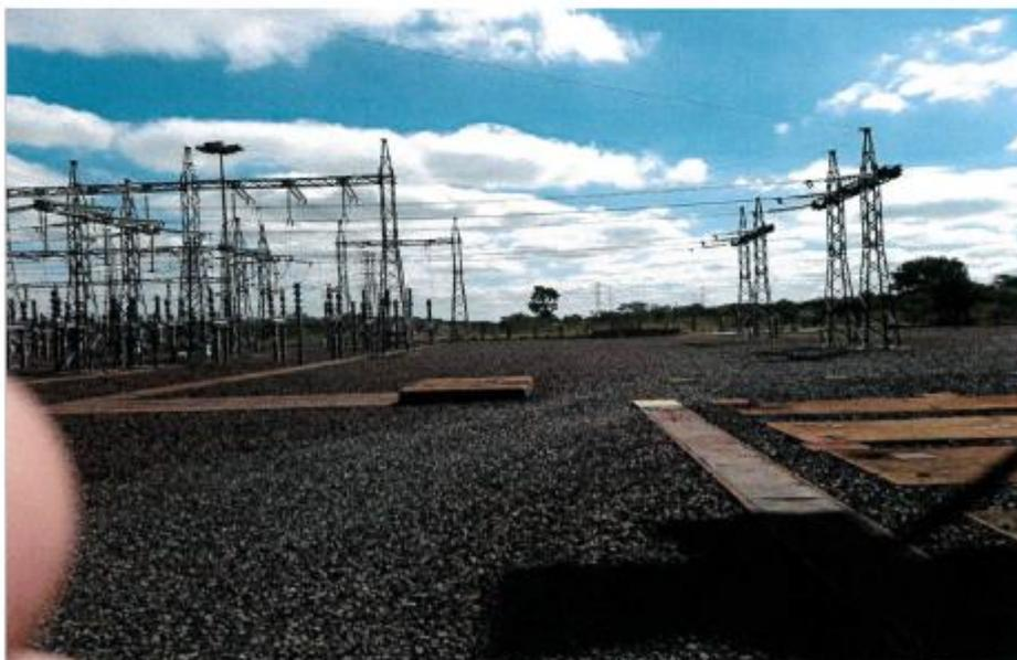
**Foto 11:** Conforme indicado na foto 10, as duas primeiras fundações de cubículo 13,8kV deverão ser retiradas.
