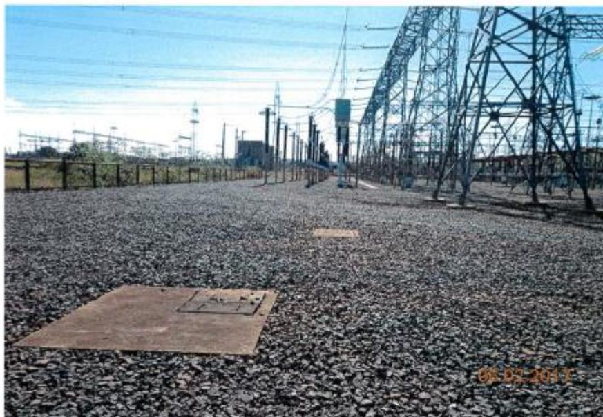
**Foto 3:** Espaço em frente ao módulo de conexão 440 kV do TR-2, para instalação das 04 fases do TR, das barras de transferência de 440 e 138 kV da fase reserva, paredes corta-fogo e das buchas 138kV do cabo isolado; observar a intervenção que será necessária na drenagem da instalação.
