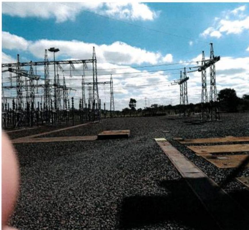
Foto 7: Espaço para instalação do bay 138 kV do novo banco de transformadores.
